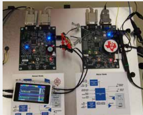
图10 带有损坏CANH线路的CAN演示系统
